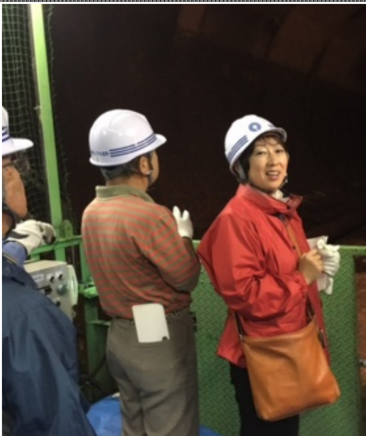
巨大貯留管前で（江川雨水貯留管内部） 参加者（写真左より松本代表、田辺（達）さん、大庭さん
