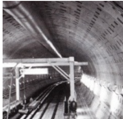
当時の地下工事現場 総工費が280億円だそうです。
